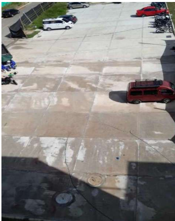
FOTO 2: Vista panorámica de los parqueaderos.
