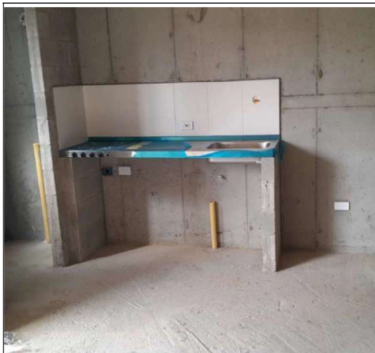
FOTO 1: Muestra instalación de mesones de cocina e instalación de enchape de salpique.
