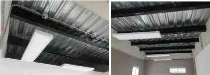
**Figuras N°24 y 25.** Corrección en Anticorrosivo y Pintura de las vigas metálicas
