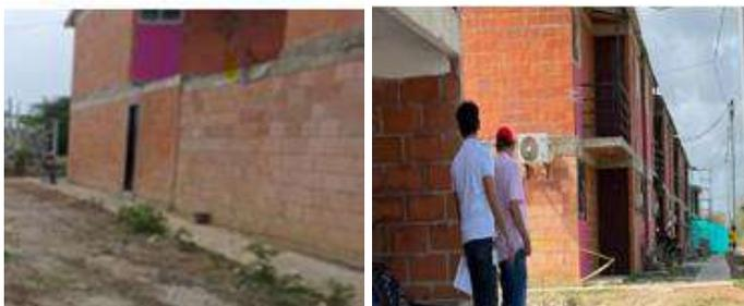
**Figuras N°19 y 20.** Muros en Fachada sin alero ni protección contra la Intemperie.
