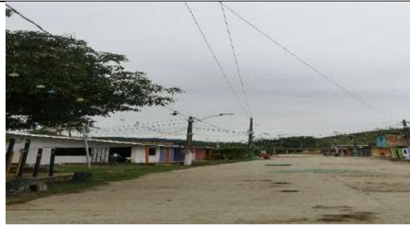
Ilustración 4. Línea ecológica 7.6 KV
