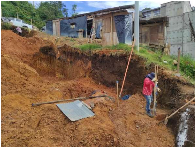
Sobre excavación y excavación de pilotes del bloque 9
