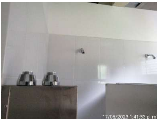
Ilustración 15. Regaderas por instalar.
