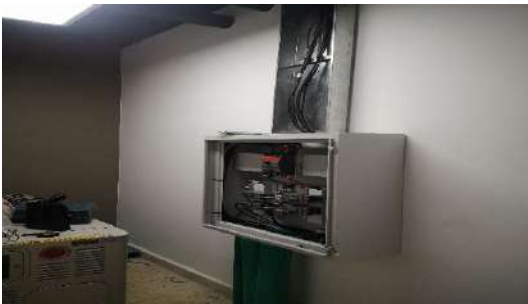
Ilustración 9. Tablero ML finalizar montaje.
