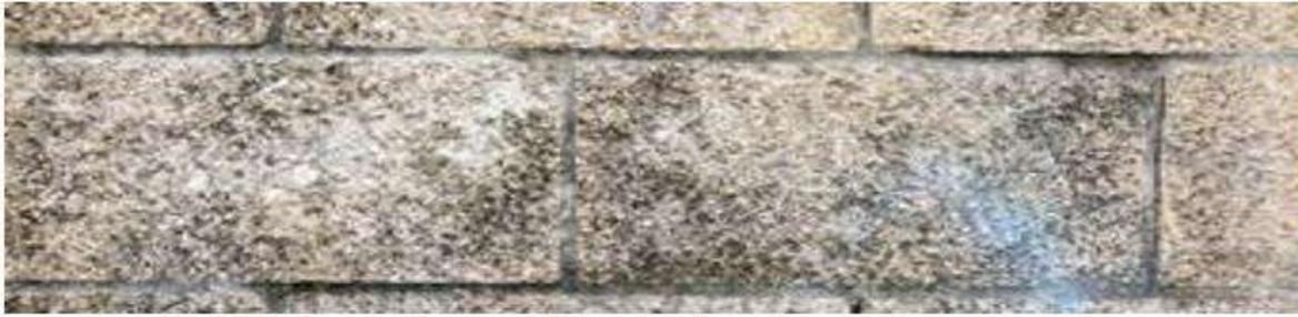
Fig.2 Deterioro en bloques debido a las circunstancias a las que se expone (sol, agua, ácidos, etc.).
