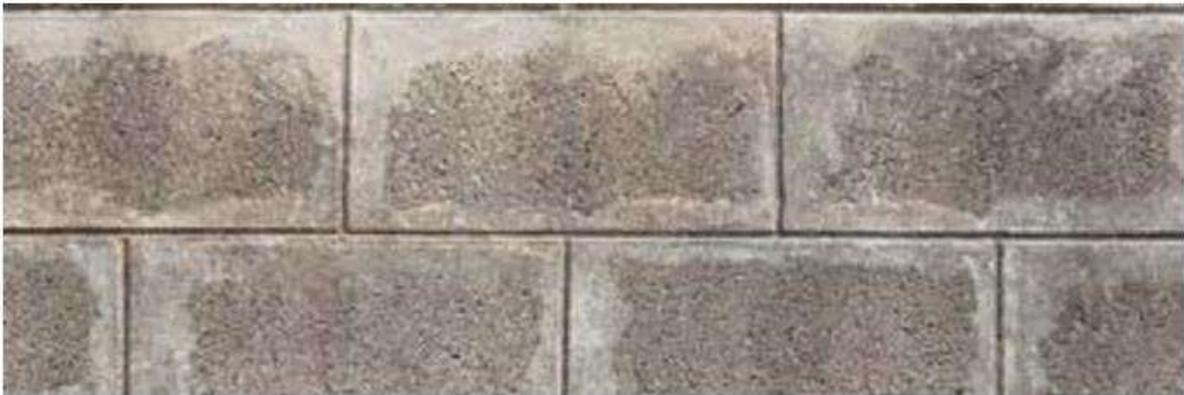
Fig. 1 Esta eflorescencia es baja en el bloque gris, se evidencia más en el bloque de color.
