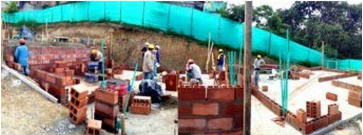
Fig. 1 Correcta colocación para almacenar adobes, lo que evitará pérdidas y/o defectos.
