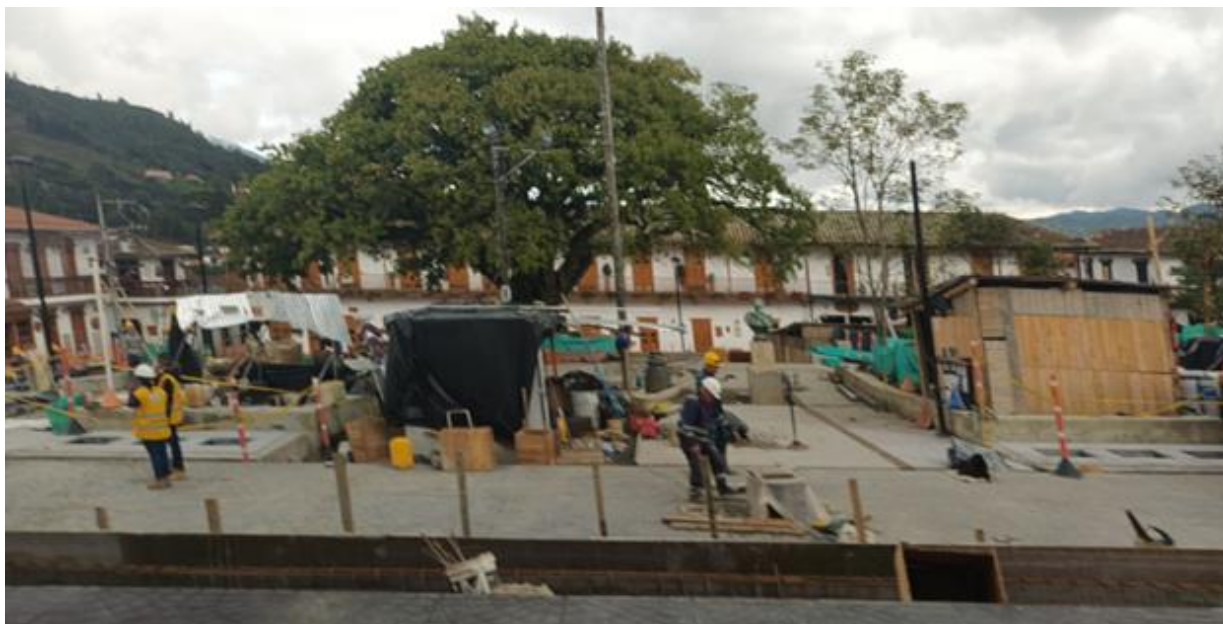
Parque Principal Municipio de El Retiro. Oriente, Municipio de El Retiro. Secretaría de Infraestructura Física.
