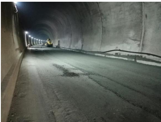
Conformación subrasante portal Cañasgordas Túnel Guillermo Gaviria Echeverri. Occidente, Municipio de Cañasgordas y Giraldo. Secretaría de Infraestructura Física.
