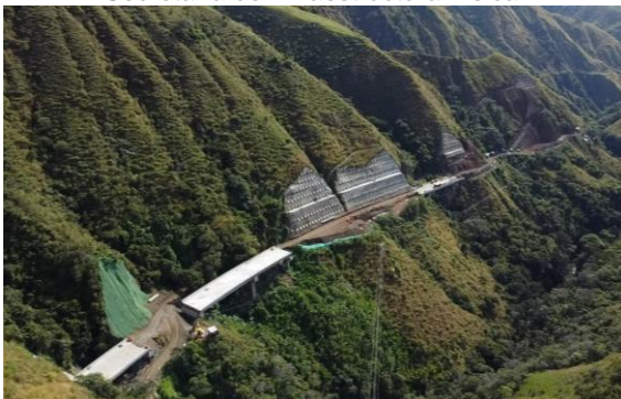
Vista panorámica, Puente 5, puente 4, taludes (3, 2, 1) y puente 1. Occidente, Municipio de Cañasgordas y Giraldo Secretaría de Infraestructura Física
