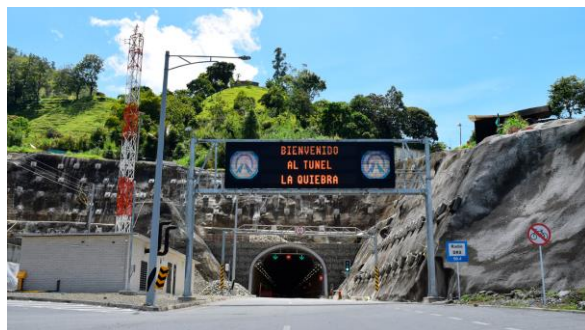
Túnel de la Quebra. Nordeste, Municipio de Santo Domingo Concesión Vías del Nus.
