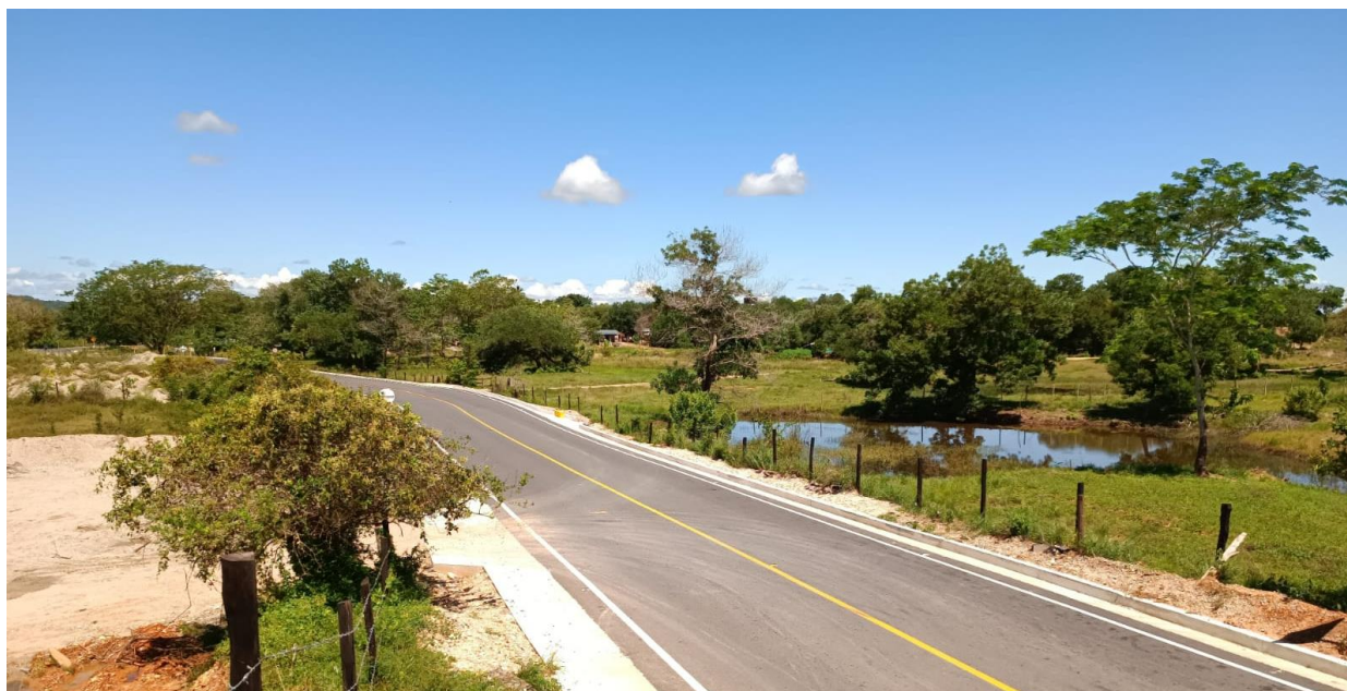
Pavimentación de la vía “Escarralao – El Bagre” Etapa 2. Bajo Cauca, Municipio de Zaragoza. Secretaría de Infraestructura Física.
