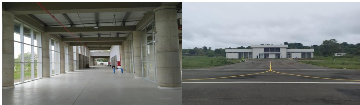
Aeropuerto de Necoclí. Urabá, Municipio Necoclí. Secretaría de infraestructura Física.
