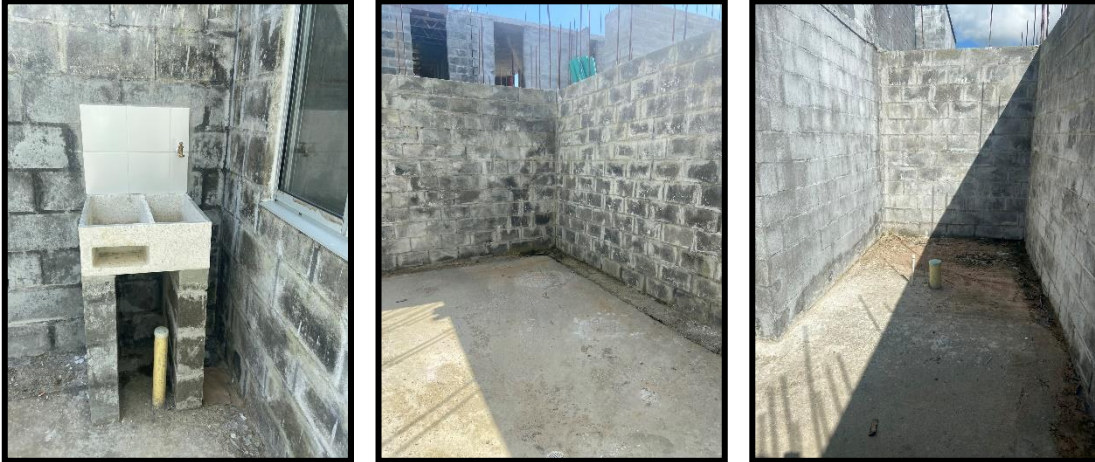
Zona de ampliación nivel 1
