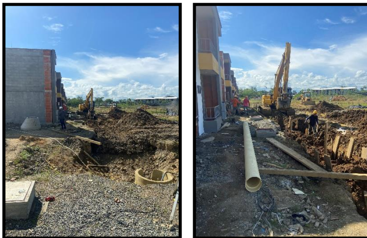
Instalación de tubería red de acueducto y alcantarillado
