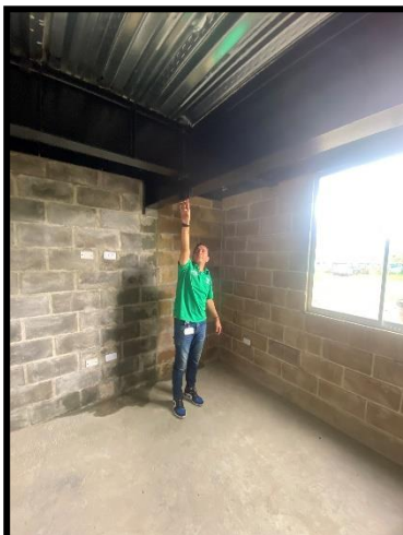
Viga central en habitación Poca altura, Viga por debajo del dintel
