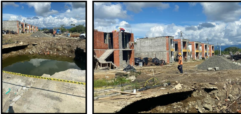
Zona de ubicación de estación de bombeo
