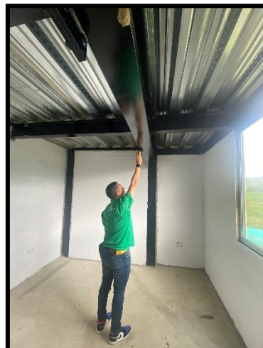
Viga central en habitación Poca altura, Viga por debajo del dintel
