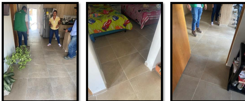
Mari Palacio Parra, corregimiento de Botero Mejoramiento de pisos
