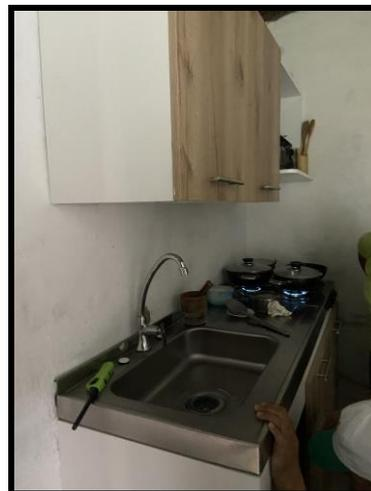
Los gabinetes, el mesón y la cubierta se encuentran en muy buenas condiciones, se identifica que el sifón flexible se encuentra con fuga por lo que no está utilizando el lavaplatos, falta por instalar los tapones en el lavaplatos.
