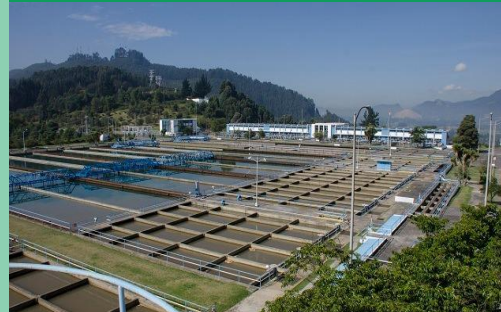
Acueducto en Bogotá
