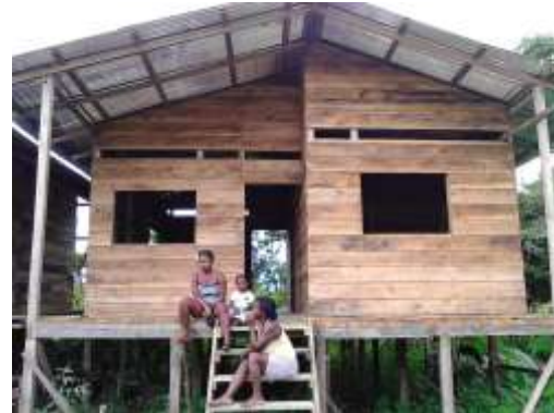
CONSTRUCCIÓN "PALAFITO" EN MURINDÓ
