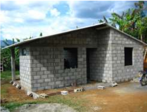
CONSTRUCCIÓN CASA T2 EN HELICONIA
